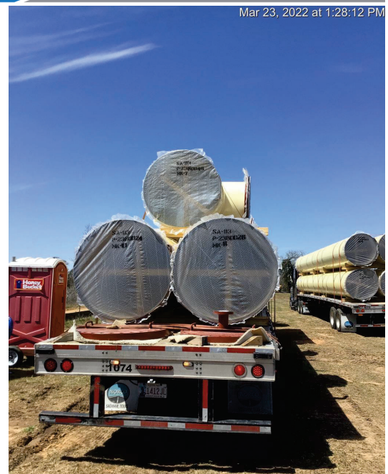
Seg A – Pipe Delivery
