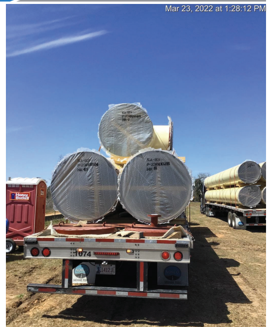
Seg A – Pipe Delivery
