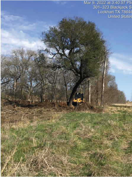
Seg A – Clearing ROW
