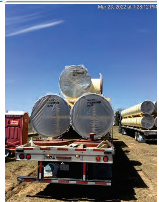
Seg A – Pipe Delivery
