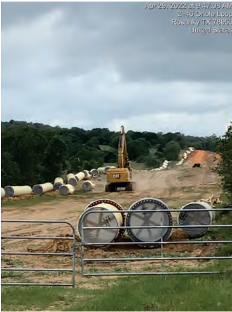
Seg A – Pipe Stringing
