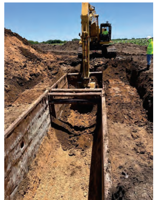
Seg B2 – Bore Pit Sta 148+37
