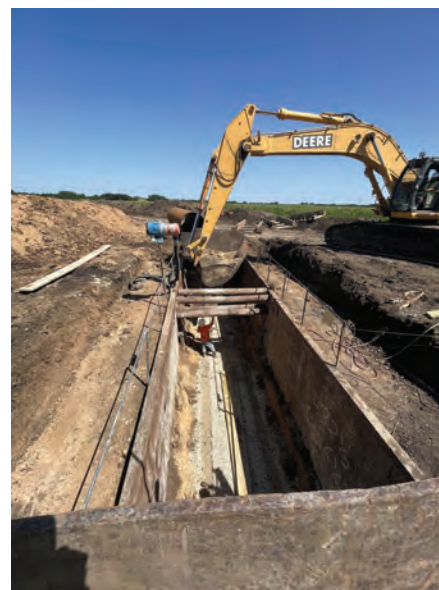
Seg B – Bore Pit Sta. 148+37 Seg B1
