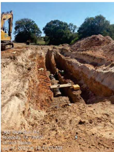
WTP – Raw Waterline WL-A at STA 14+05
