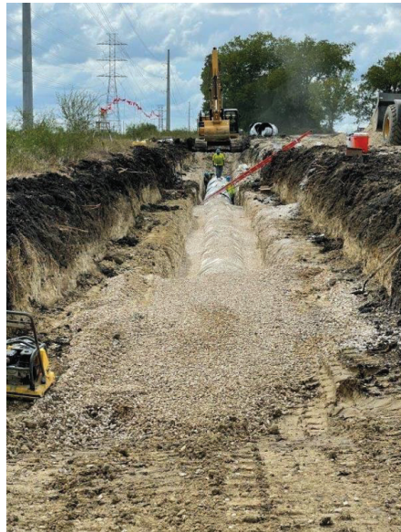
BPS – Seg B1 42" DIP near STA 3+40
