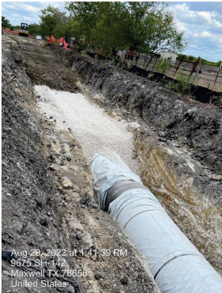
BPS – 42" DI Seg B1 near STA 6+00
