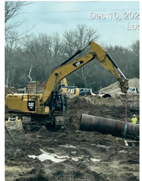
Seg A – STA 671+00 - Casing Placement
