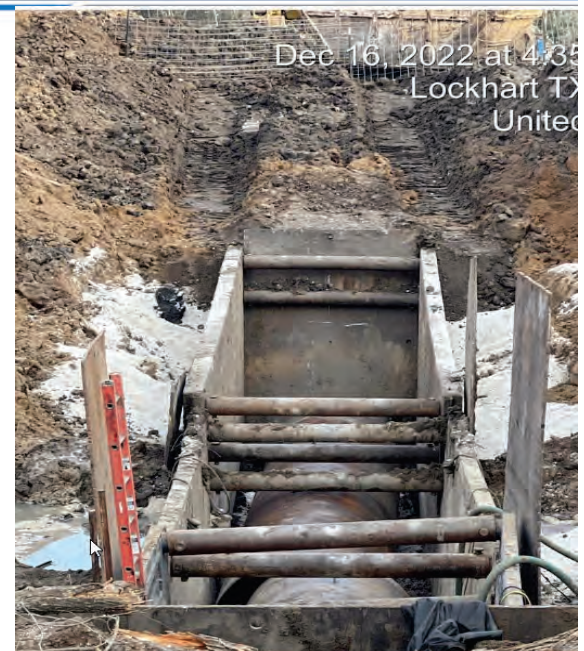
Seg A – STA 671+00 - Casing Set
