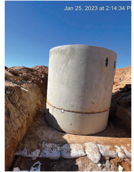
Seg A – Setting Concrete Riser
