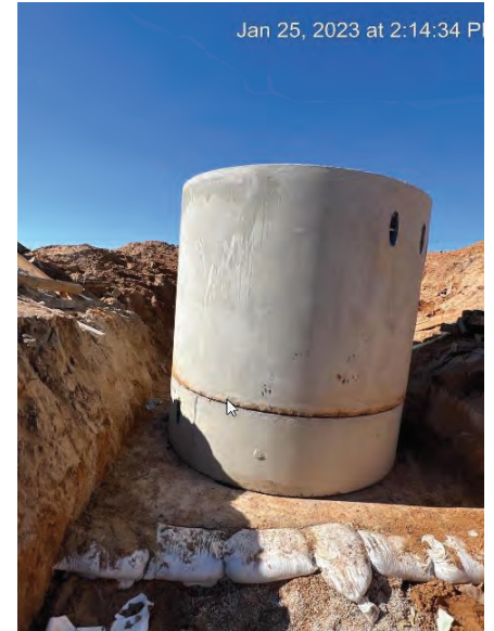
Seg A – Setting Concrete Riser
