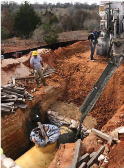
Seg A – Concrete Pour
