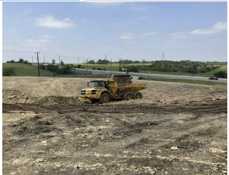
EST - Excavating Existing Pond for EST Foundation
