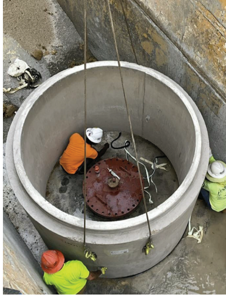
Seg A – Installing Manhole section
