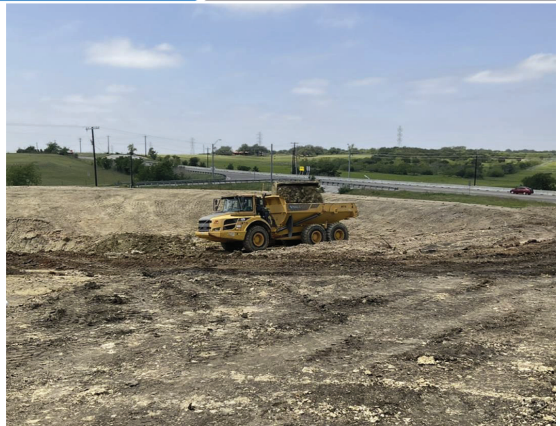
EST - Excavating Existing Pond for EST Foundation
