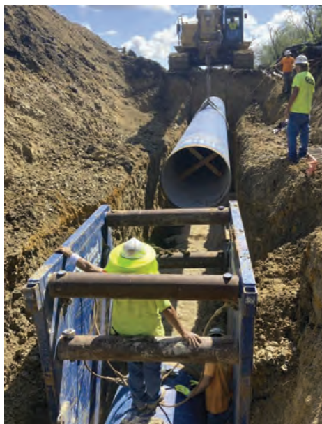
Seg B – Installing Pipe
