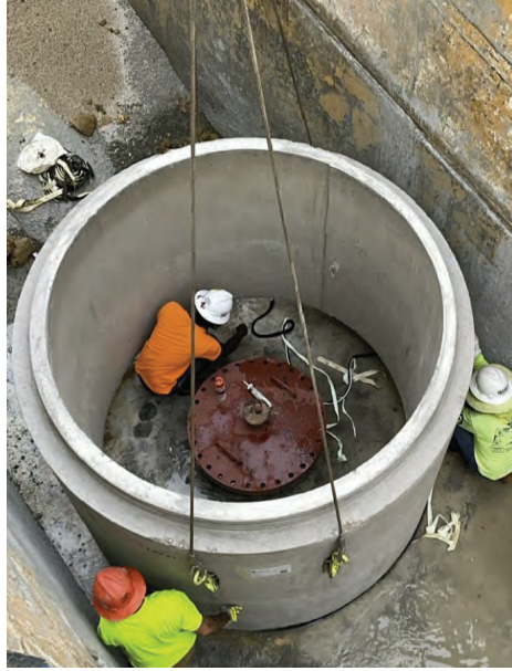
Seg A – Installing Manhole section
