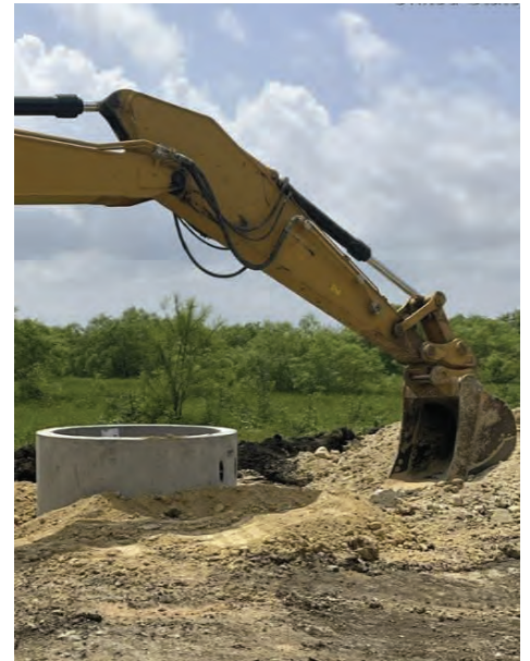
Seg A - Setting Manhole section at STA 854+68 11
