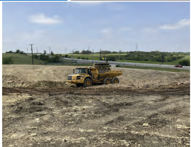
EST - Excavating Existing Pond for EST Foundation
