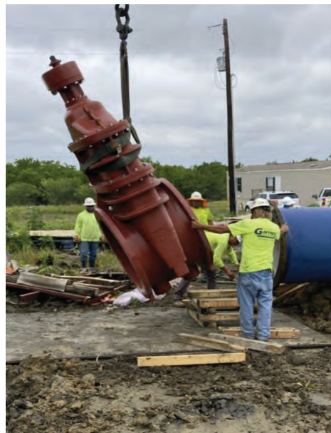
Seg B – STA. 377+08 Gate Valve Assembly
