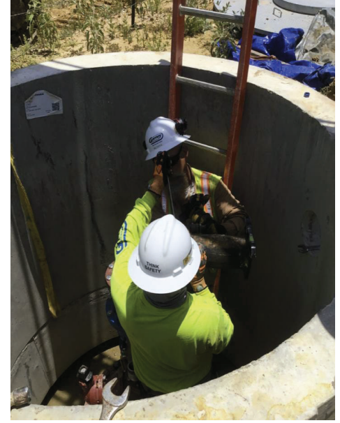
Seg A - Installing Air Relief Valve at STA 33+50 11
