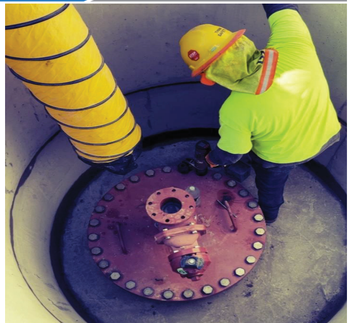
Seg A – Garney Torques Air Relief Flange
