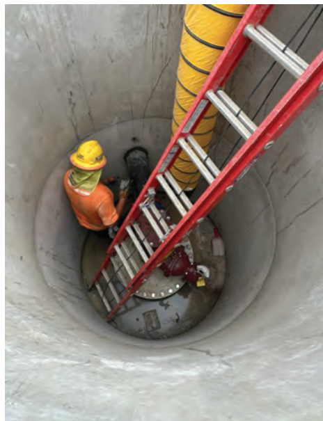
Seg B – STA 535 + 71 Installing Drain Valve
