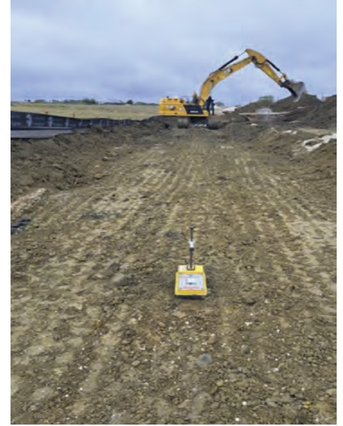
Seg D – Backfill Testing
