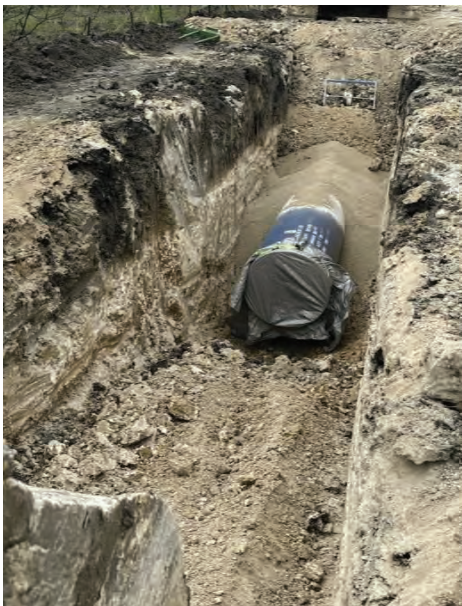
Seg B – STA 46+15 End of Pipe
