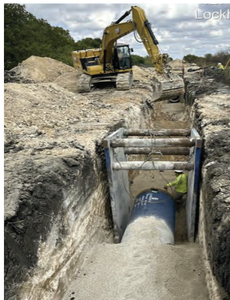
Seg B – STA 46+15 Side Digging
