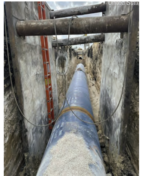
Seg B – STA 45+16 End of Pipe
