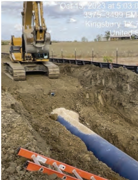
Seg D – Backfill
