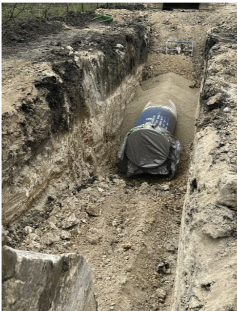
Seg B – STA 46+15 End of Pipe
