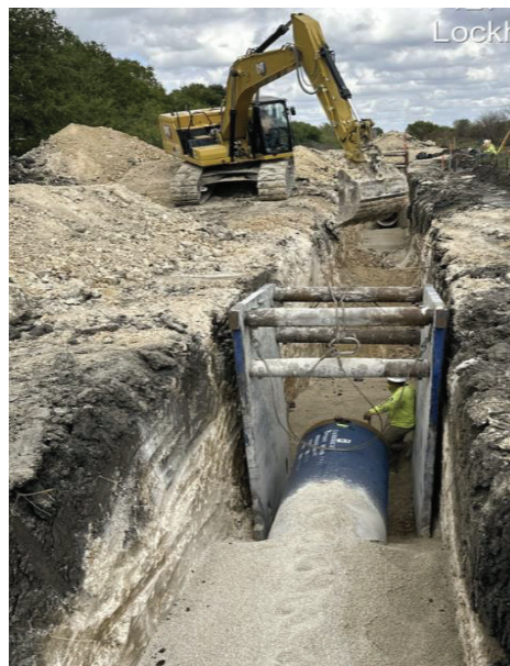
Seg B – STA 46+15 Side Digging
