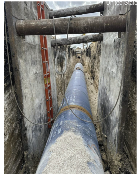
Seg B – STA 45+16 End of Pipe
