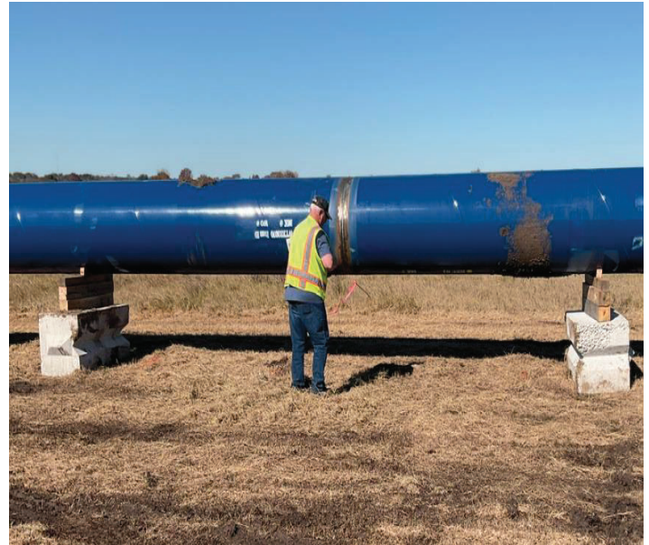
Seg E – Testing HDD Pipe
