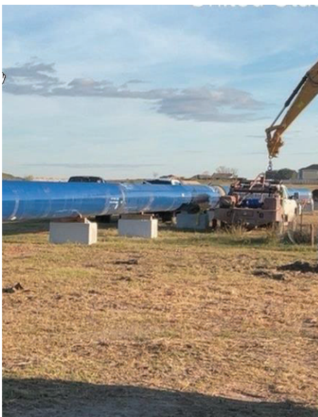
Seg E – HDD Pipe
