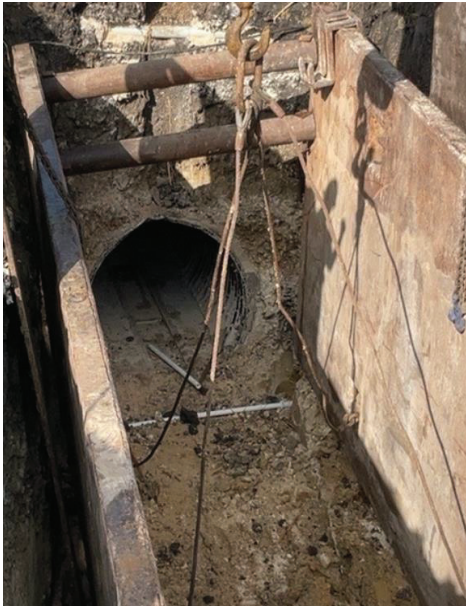
Seg D – Shorebox Install
