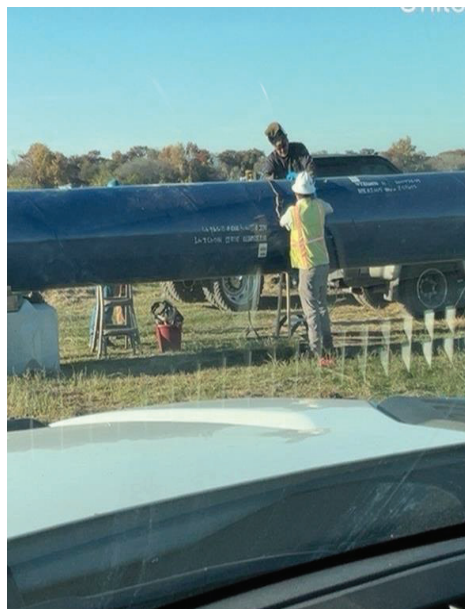
Seg E – Welding HDD Pipe
