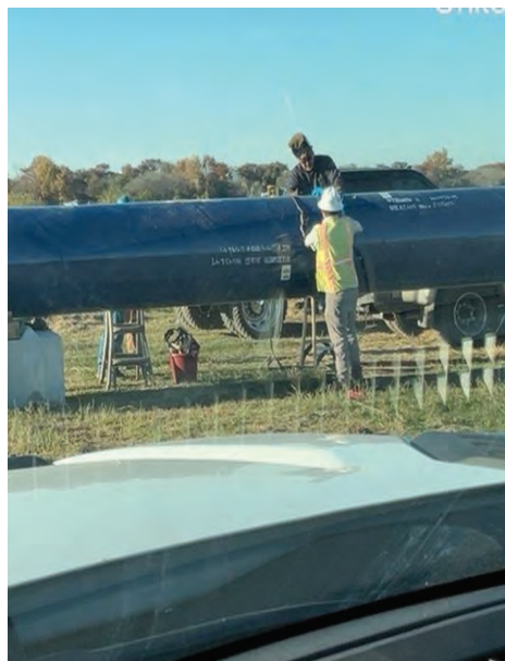
Seg E – Welding HDD Pipe
