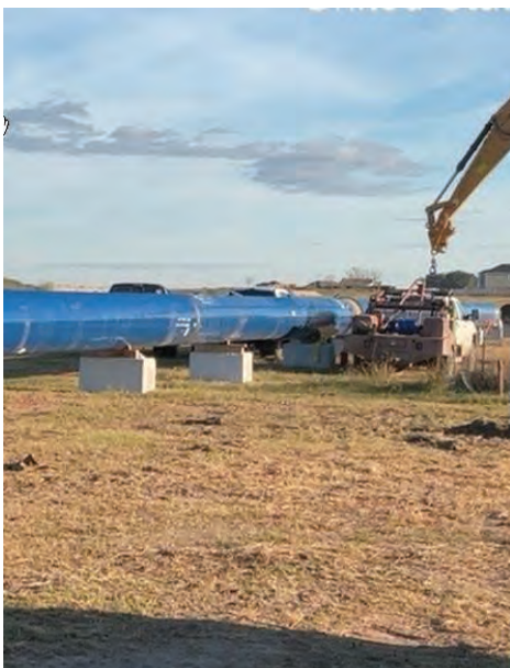
Seg E – HDD Pipe
