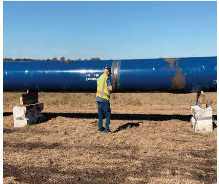
Seg E – Testing HDD Pipe
