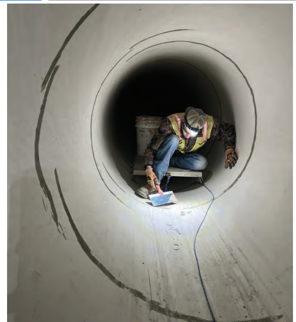
Seg A - Debris Cleanup
