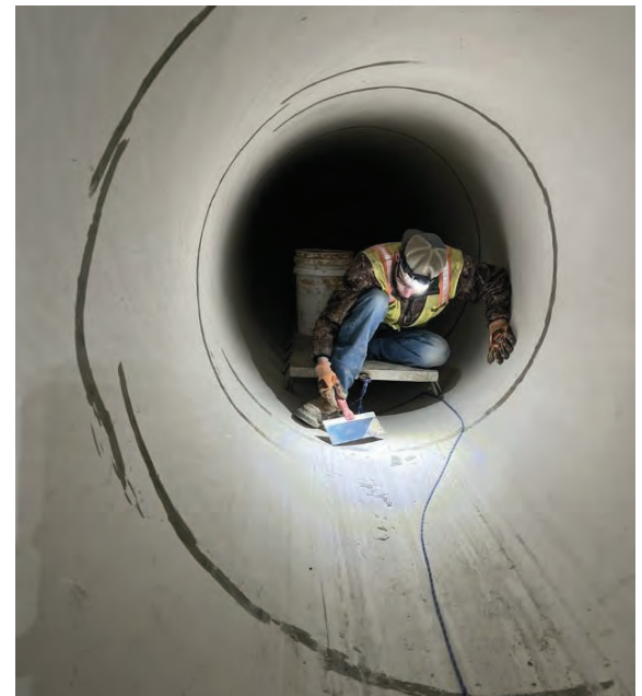
Seg A - Debris Cleanup
