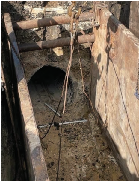
Seg D – Shorebox Install
