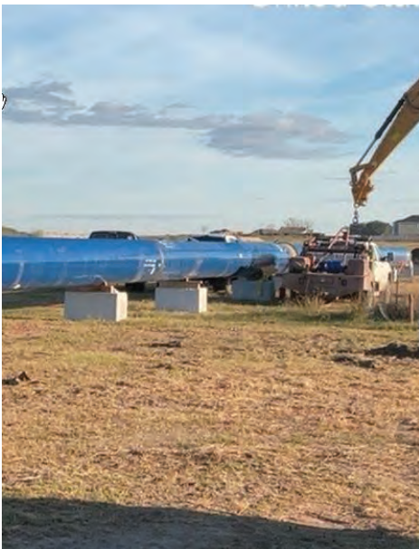
Seg E – HDD Pipe
