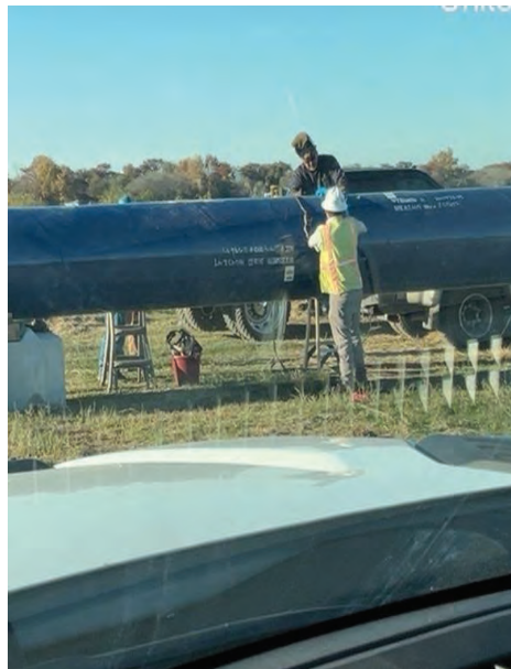
Seg E – Welding HDD Pipe
