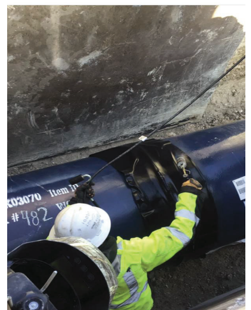
Seg E – Crew Installing Canusa
