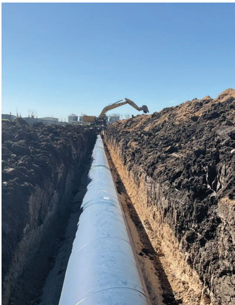
Seg E – Backfilling Pipe
