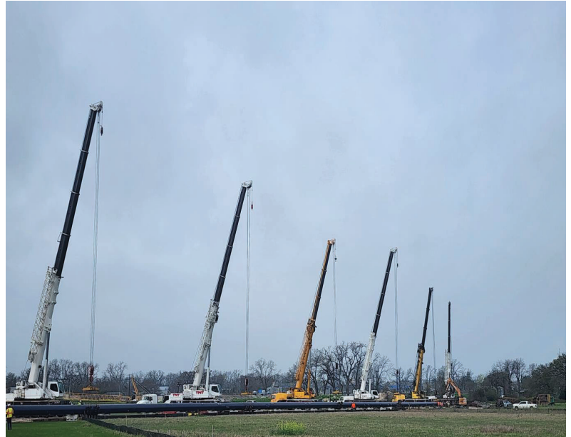
Seg E – HDD Pipe Lift
